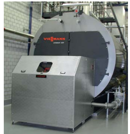
Bild 76: Brennergebläse-Schalldämmhaube
