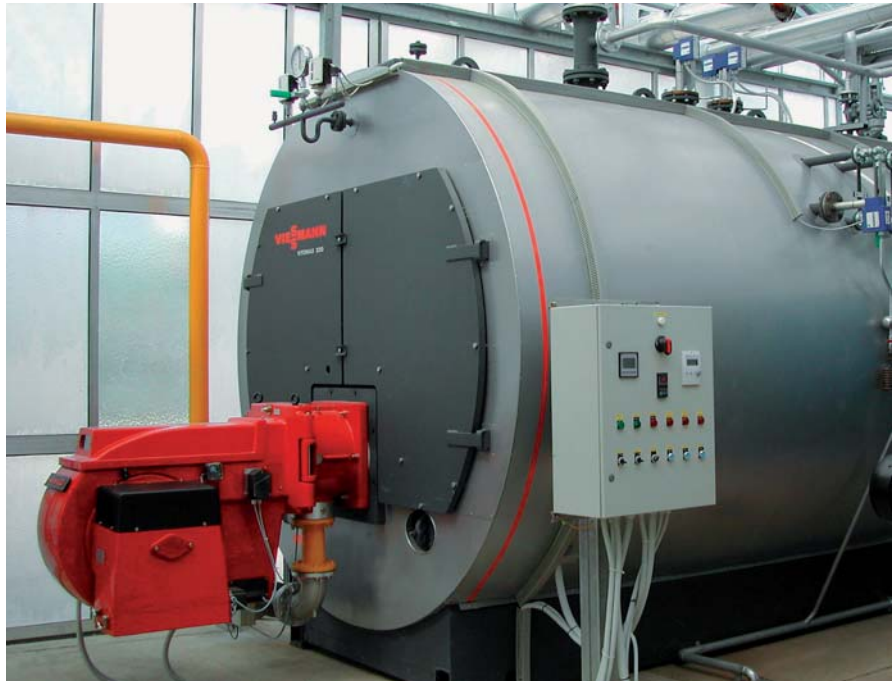
Bild 64: Hochdruck-Dampferzeuger Vitomax 200 HS (4 t/h, Gärtnerei)
