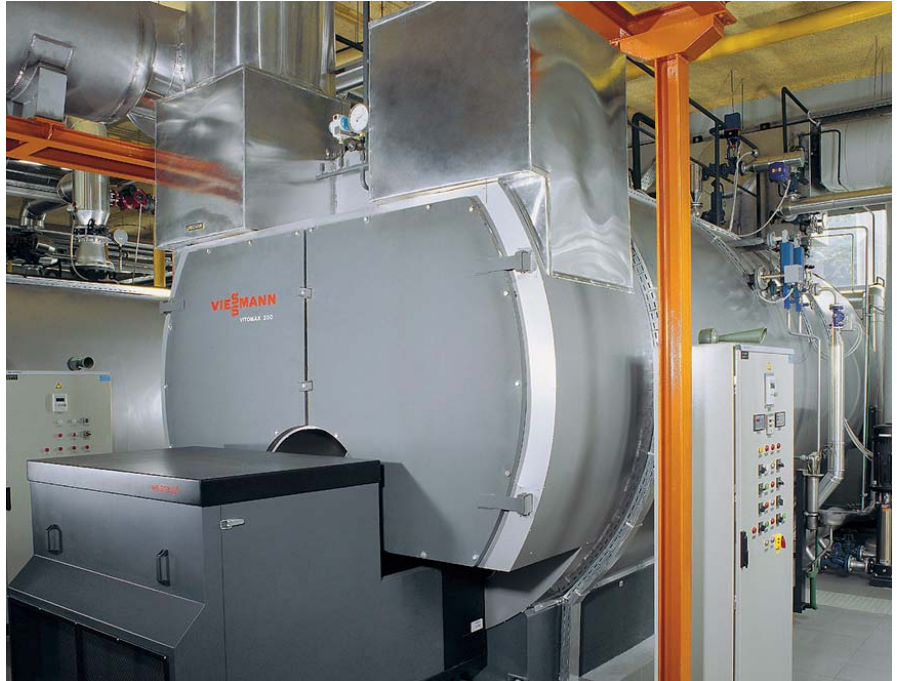
Bild 91: Vitomax 200 HS Dampferzeuger mit Abhitzenutzung im Krankenhaus in Maribor, Slowenien (6 t/h, 13 bar Sattdampf)
