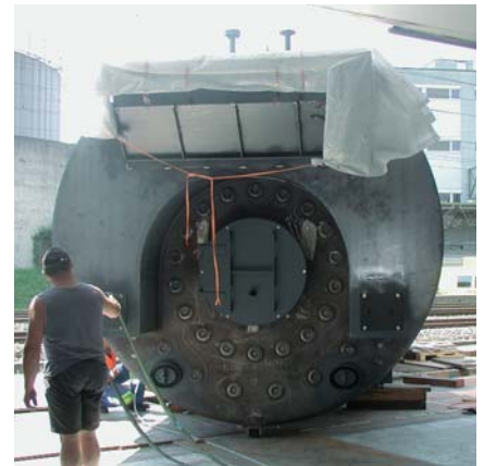
Bild 82: Einbringung ohne Wärmedämmung
