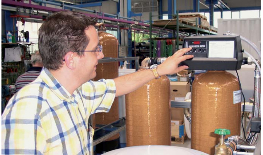
Bild 49: Parametrierung der Ionenaustauscheranlage
