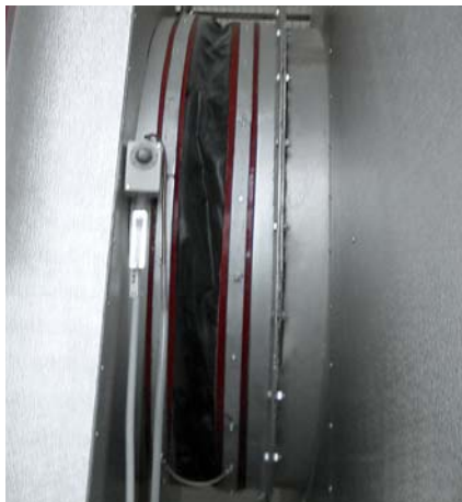
Bild 75: Abgasrohrkompensator
