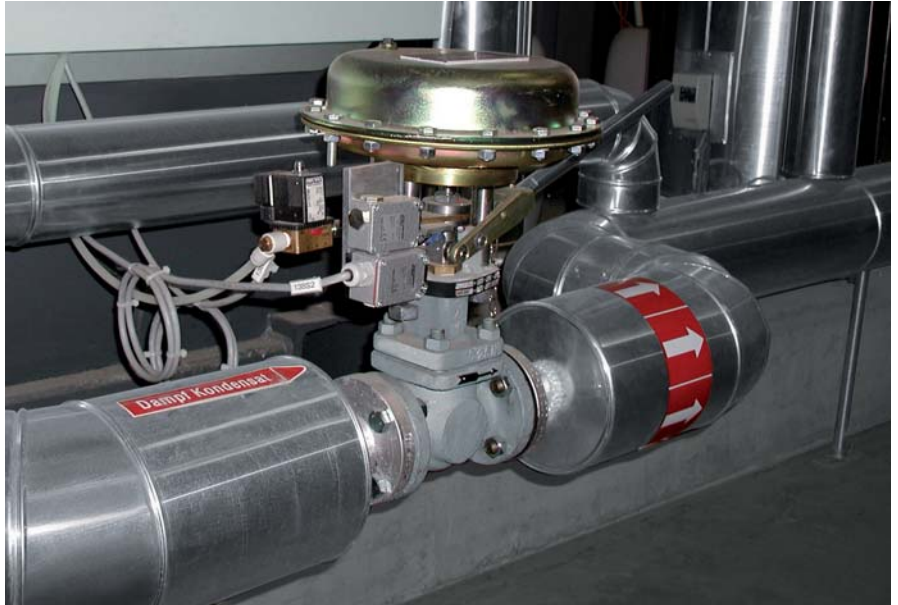
Bild 31: Automatisches Ventil zum periodischen Abschlammen des Kessels
