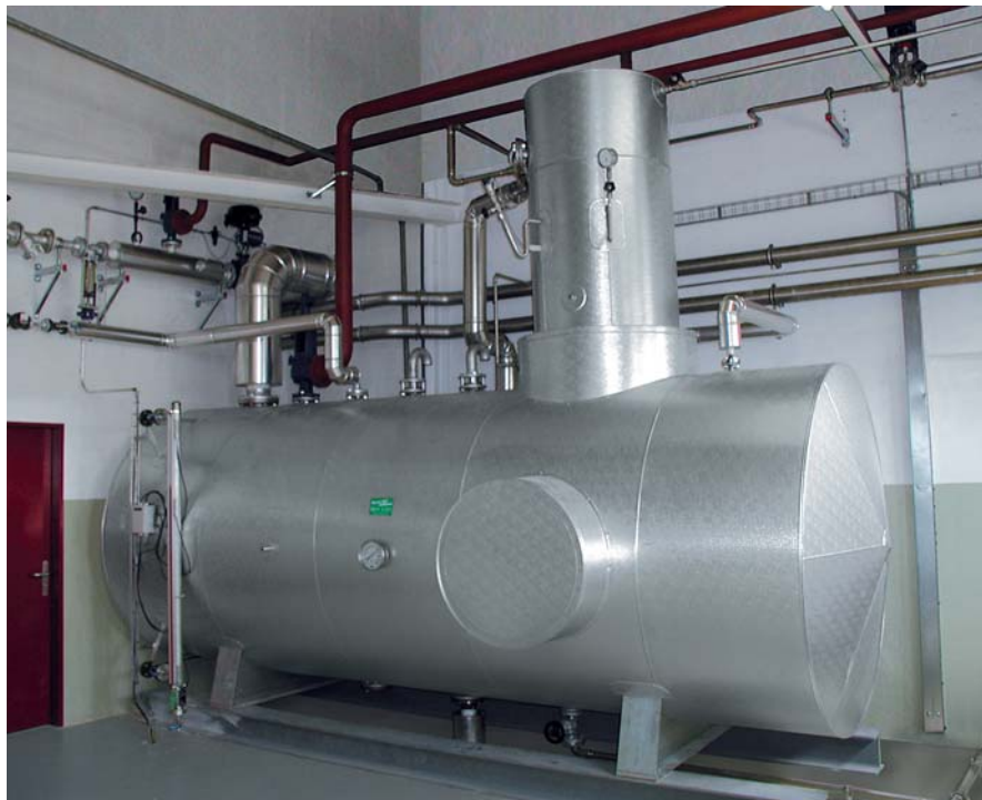
Bild 56: Speisewassergefäß mit thermischer Entgasung
