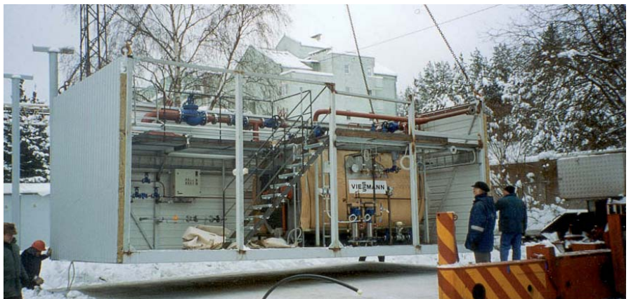
Bild 84: Einbringung eines Vitomax 200 HS (Typ M237) in Estland
