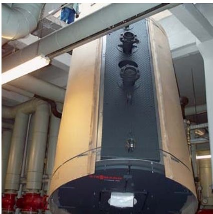
Bild 83: Einbringung eines Kessels durch das Dach
