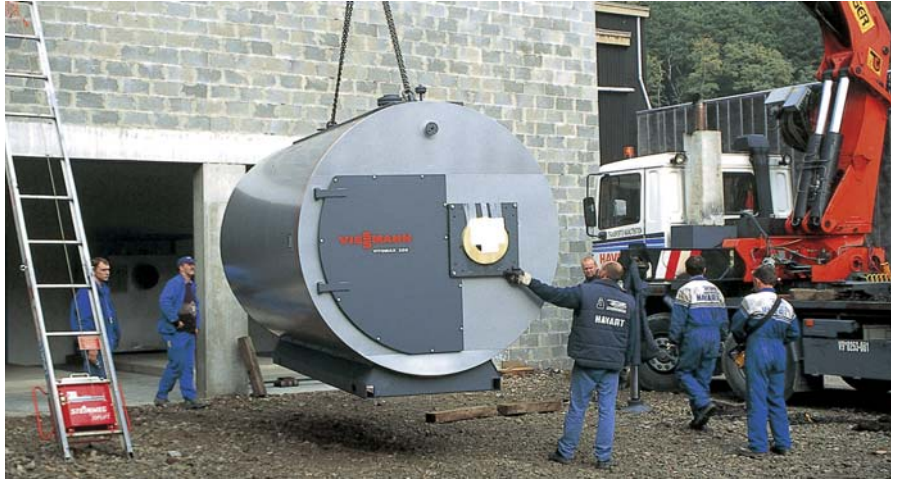
Bild 80: Die Einbringung eines Großkessels erfordert Erfahrung und Fingerspitzengefühl
